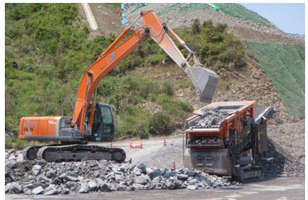
写真 1 仮置場での分級状況写真
