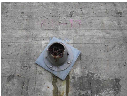
写真 3 A1-13 アンカーの状況
