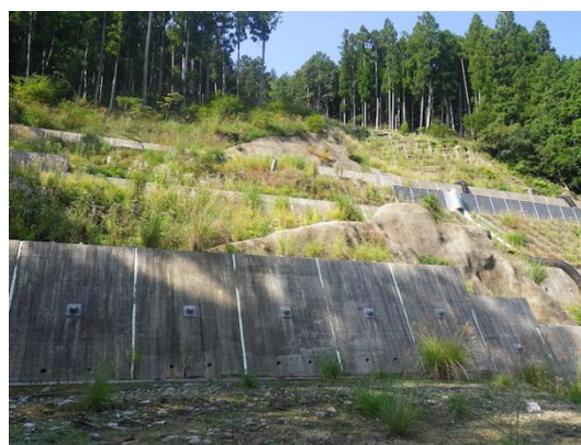
写真1 現地のアンカー施工状況
