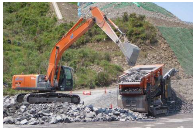
写真 1 仮置場での分級状況写真
