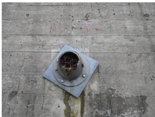
写真 3 A1-13 アンカーの状況
