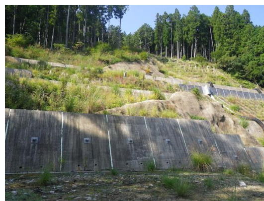
写真1 現地のアンカー施工状況
