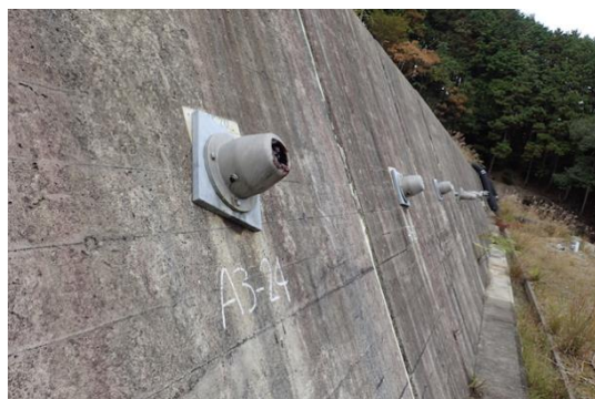
a) アンカーの状況
