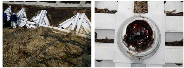
写真-5 アンカーの被災状況
