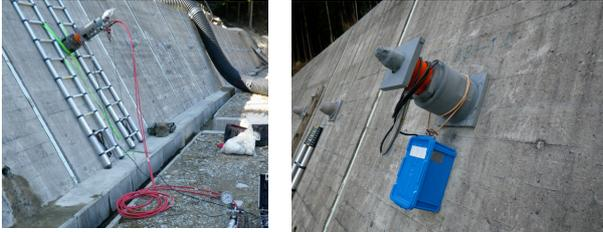
写真-8 荷重計の設置
