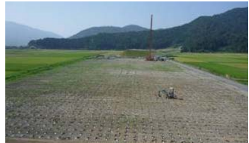
写真 3 向笠地区における PBD 施工状況
