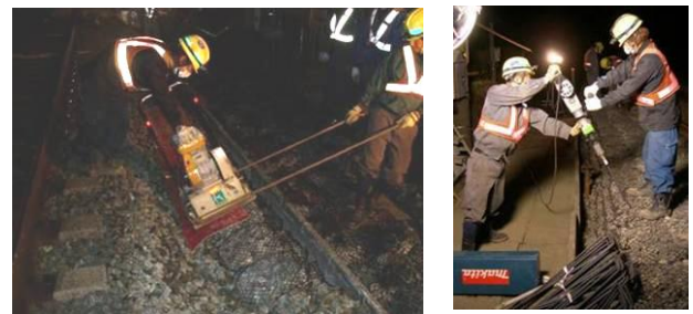
図-22 施工性試験状況(傾斜積み、コ型補強鉄筋の打込み)
