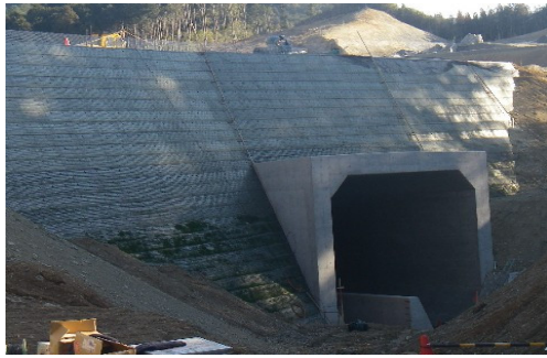
写真-3 補強盛土の施工状況
