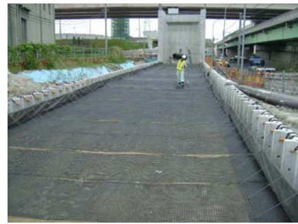
写真-2 ジオテキスタイルの敷設状況
