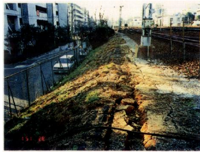
図-12 鉄道盛土の被害事例
