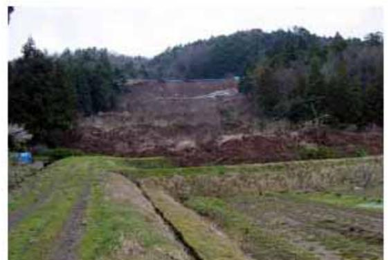
写真-1 崩壊後の対象谷埋め盛土斜面
