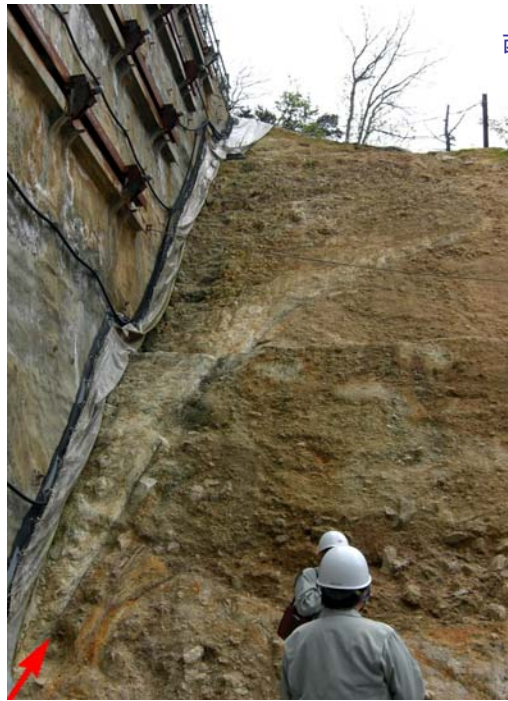
電力会社によるトレンチ調査 公開(2008年5月)
