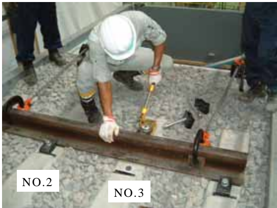
写真2 道床バラスト横抵抗力の測定状況
