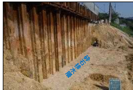
写真-10 砕石排水層
