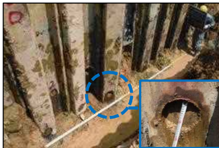
写真-9 既設鋼矢板穿孔
