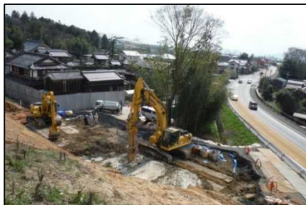
写真-8 地盤改良工
