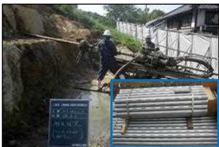
写真-11 水抜きホース （有孔管配置）
