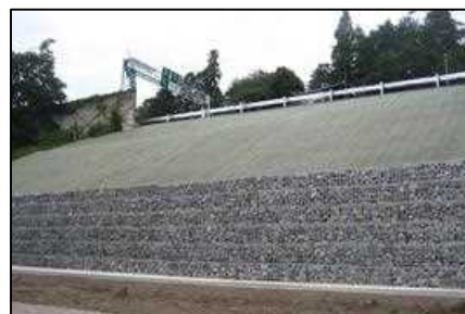
写真-13 本復旧対策工事完了
