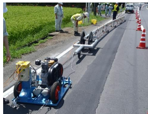
写真-3 自動化試作機による現地調査
