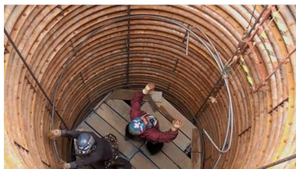
図-7 フープ筋の運搬
