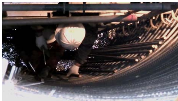
図-9 深礎最深部での主筋の建込み（近景）
