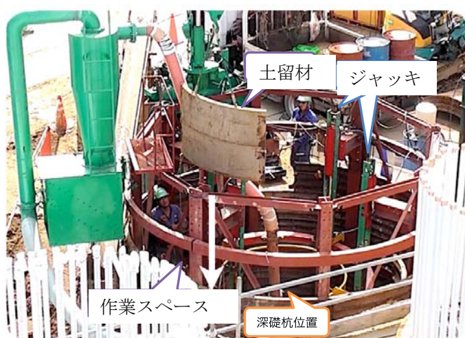
図-2 ライナープレートの組立て
