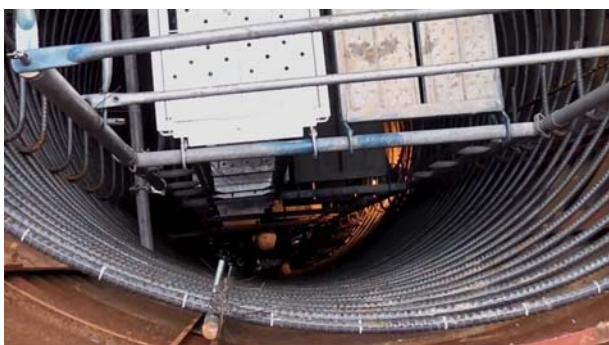
図-8 深礎最深部での主筋の建込み
