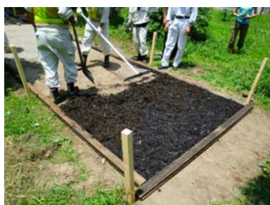
写真 2-8 敷きならし状況
