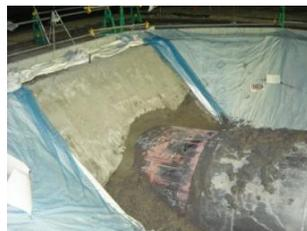
③シールド通過により発生したテールボイドに裏込め材を充填し、坑口を仕上げる。
