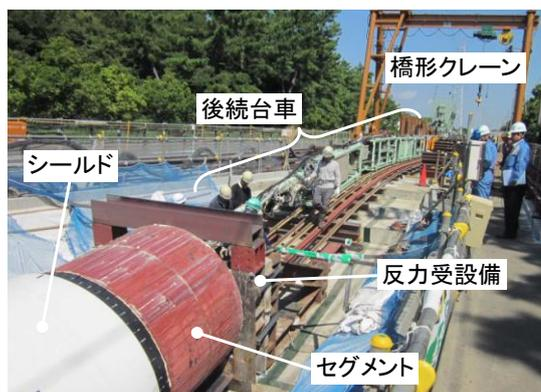
写真-2 発進時シールド後方設備
