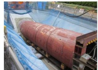
④ テールポイドを裏込め材で充填し坑口を仕上げる。
