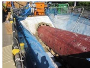
③ 土被り増加に伴い推力が上昇するため、仮セグメントの浮上りを防止しながら掘進を継続する。
