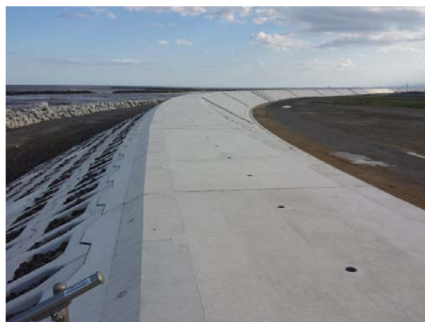
図-3.1 海岸堤防復旧構造例（文献 25) を一部修正）
