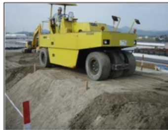
④処理土転圧状況
