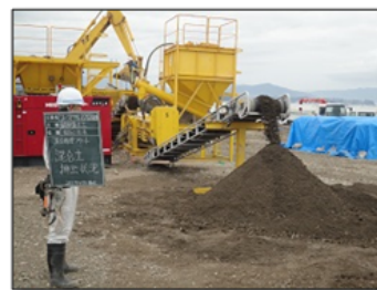
②津波堆積土の処理
