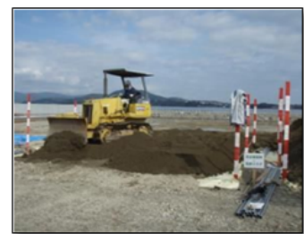
③処理土敷き均し状況
