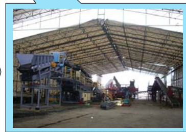
仮設プラントでの 破碎選別処理
