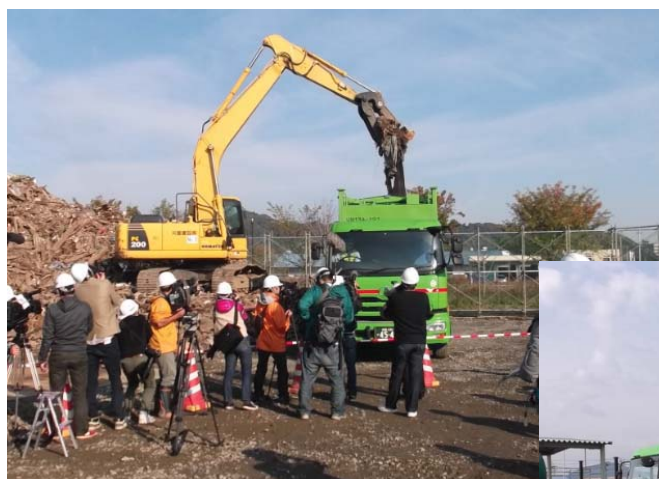
積込みの様子
