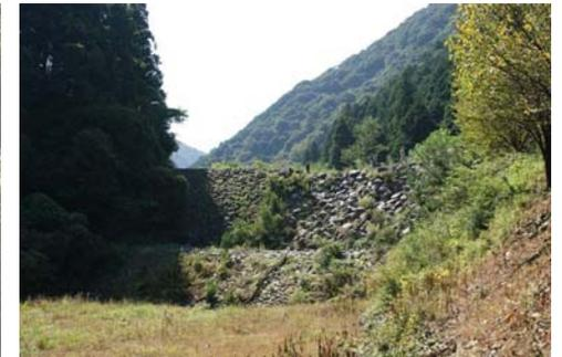
岐阜県南濃町羽根谷巨石積堰堤(明治時代,ヨハニス・デ・レーケ)
