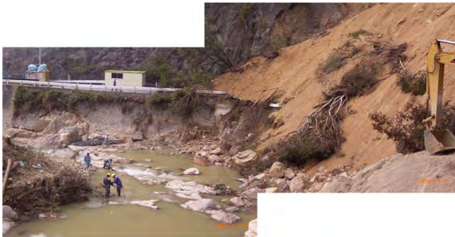
崩土(マサ土)の堆積により道路が埋没
