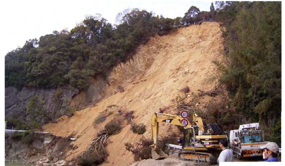
大規模な斜面崩壊(H:45m, W:40m)
