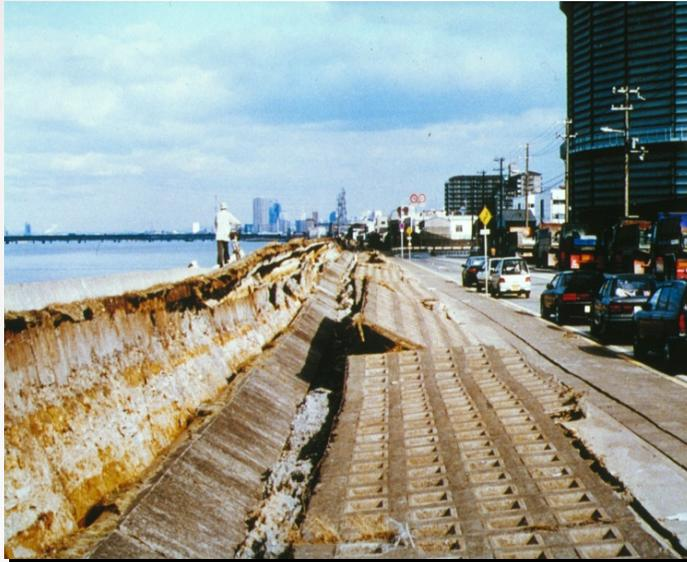
液状化による淀川堤防の被害
