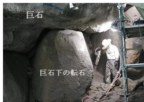
写真-6 接着根固め工の施工状況
