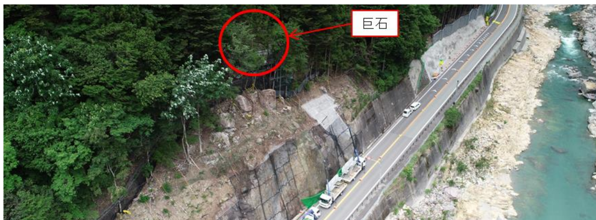
写真-3 対象箇所周辺の状況
