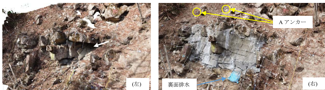
写真-7 試験施工③の状況 (2022/2/18～19 に施工)
