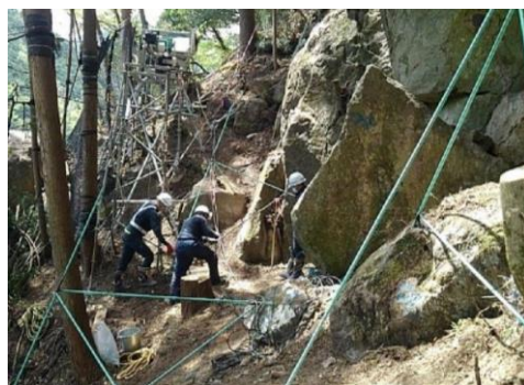
写真-5 3次元測量による位置出し
