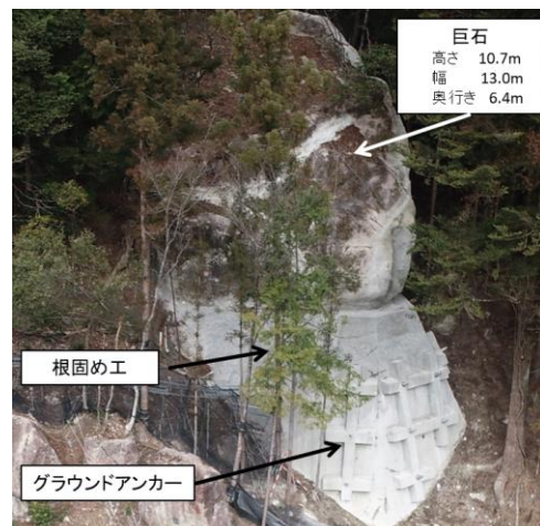
写真-2 落石対策工の完成
