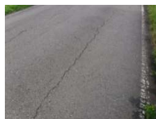
図-4 縦断亀裂
