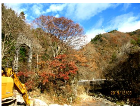
写真-1 伊奈川为天橋跡（正面北東）の矢垂沢のむこうに勝負平）
