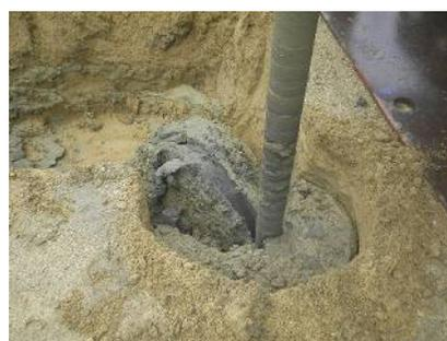
写真-6 LDis-Dy 改良時の軟泥土排出土状況
