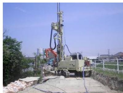
写真-5 自走式 LDis-Dy 施工機による堤体部施工状況
