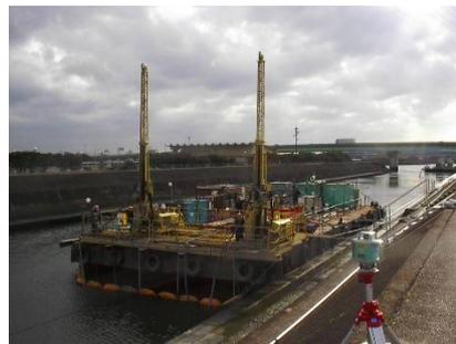
写真-1 台船上に搭載した SJMM-Dy 施工機全景
