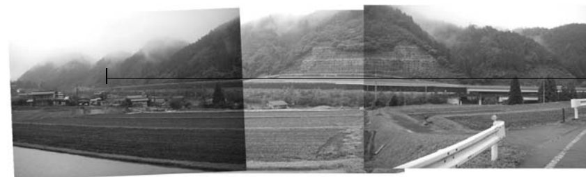
補強土壁遠景
