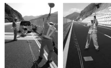
探査状況写真
