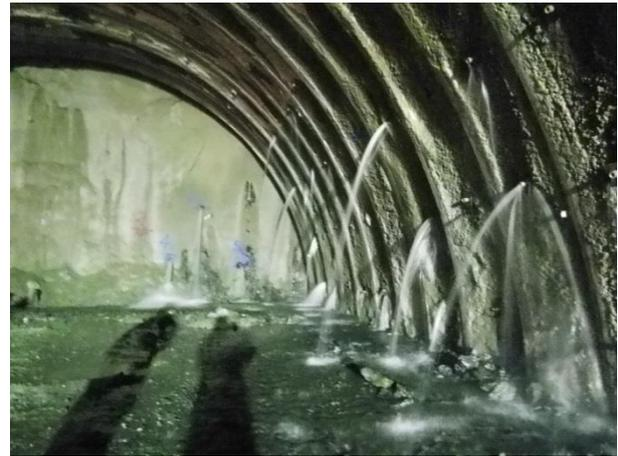
写真-2 トンネル掘進後の壁面からの湧水状況
