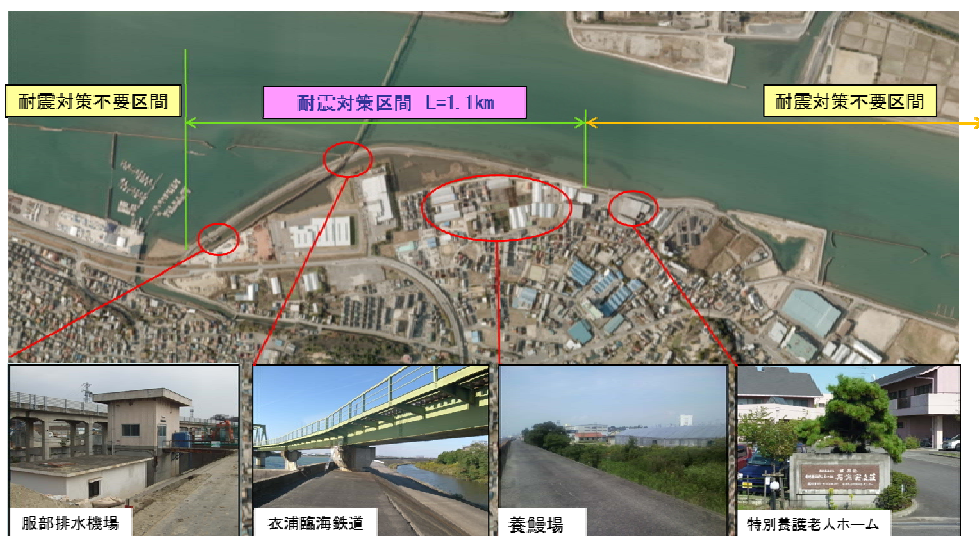
写真-2 施工箇所航空写真
