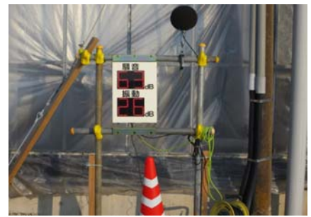
写真-6 騒音・振動調査状況近接撮影
