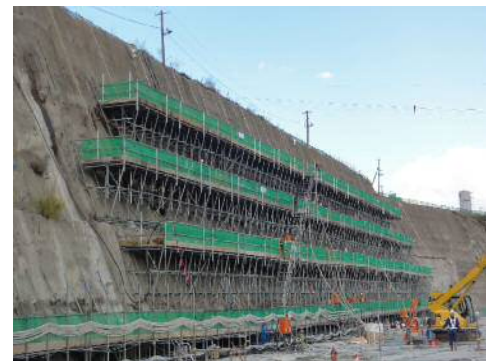
図-7 法面部コンソリデーショングラウト施工状況
