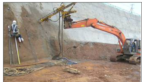
図-4 ロックボルト施工状況
