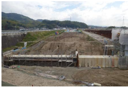
図1 開削工事中の堤防
