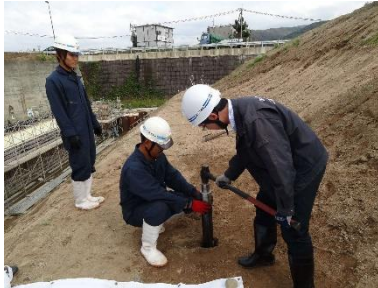
図5 サンプラーの打ち込み(方法B)
