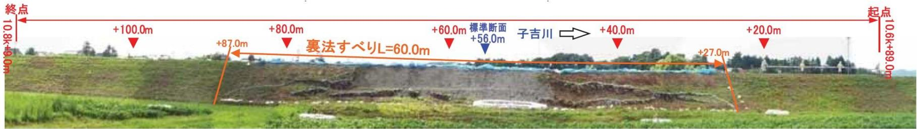
図 子吉川堤防被災状況(東北地方整備局提供)
