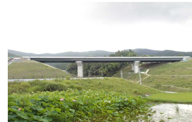
周辺環境にふさわしい鋼桁の配色
