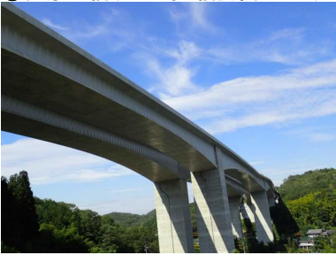
③豊田巴川橋(豊田市) (波型鋼板ウエブ 最大支間長160m)
