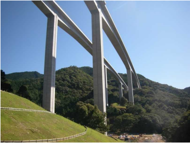
①佐奈川橋(豊川市:橋脚高さ89m)
