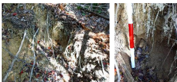
(a) 遠景 (b) 拡大 写真-2 パイピングの痕跡(広島市安佐南区八木) (撮影日: 2014 年 11 月 3 日)
