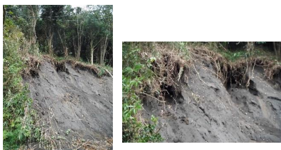
(a) 遠景 (b) 拡大 写真-1 パイピングの痕跡(東京都大島町元町) (撮影日: 2013 年 11 月 9 日)
