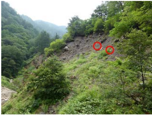
写真6 土壌硬度計の貫入による火山礫および火山礫に挟まれ箇所（上流側）の計測箇所
