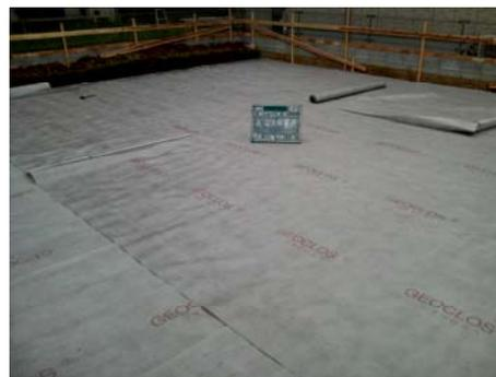
図1 ジオシンセティックスによる支持力補強
