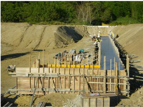
写真 4-2 雨水排水管の施工
