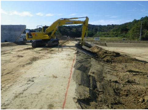
写真 4-1 ベントナイト混合土斜面部の施工
