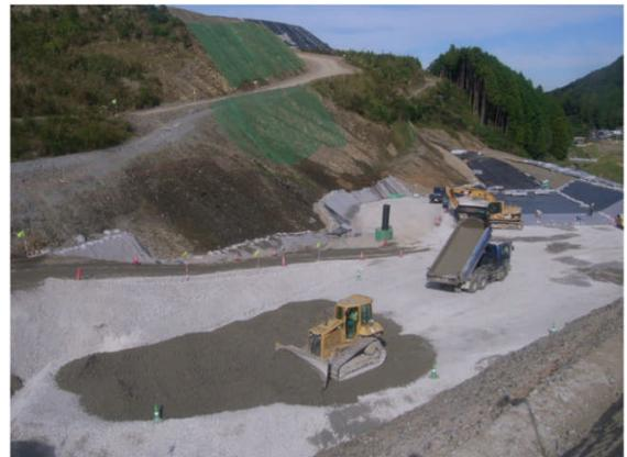
写真 5-3 不溶化盛土施工状況
