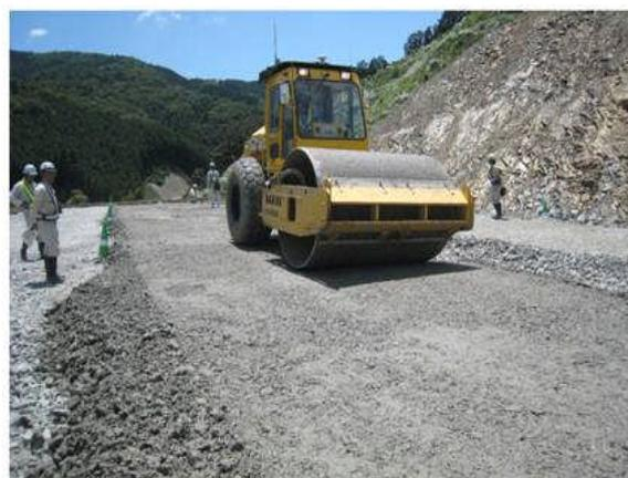
写真 5-1 固化・不溶化モデル施工
