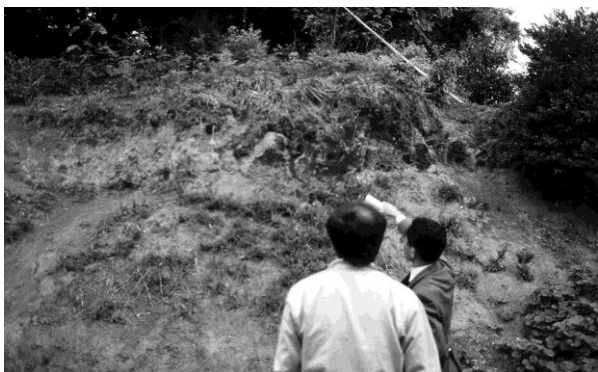
写真2 坊の塚古墳前方部崩落断面（1992年）
