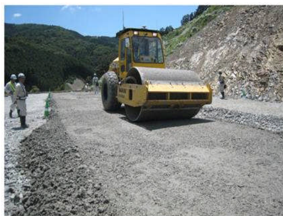
写真 5-1 固化・不溶化モデル施工
