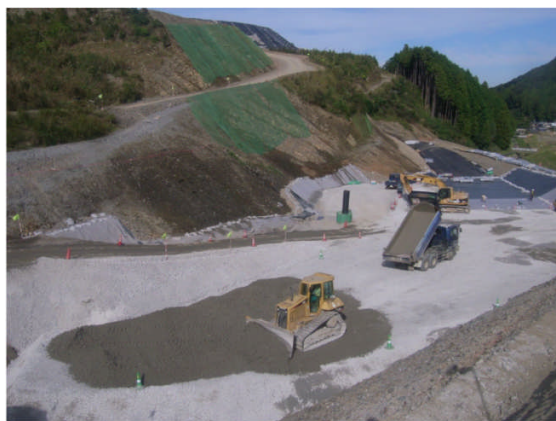
写真 5-3 不溶化盛土施工状況
