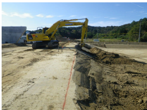
写真 4-1 ベントナイト混合土斜面部の施工
