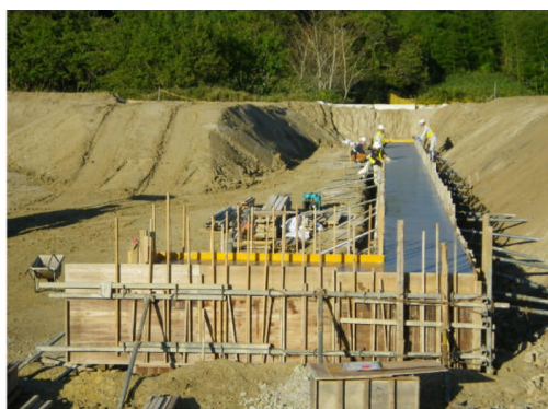
写真 4-2 雨水排水管の施工
