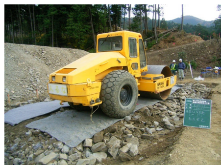
写真 4-4 遮水シート破断実験
