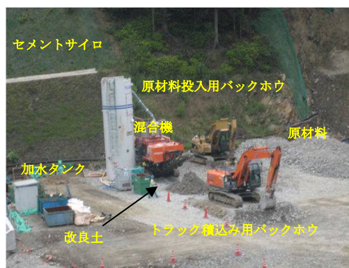
写真 3-1 セメント改良土製造プラント
