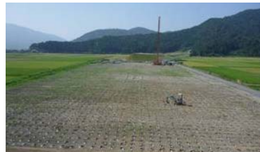
写真 3 向笠地区における PBD 施工状況
