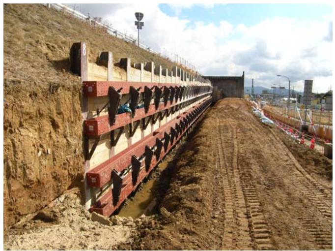
写真, 3 土留め工完成後の状況
