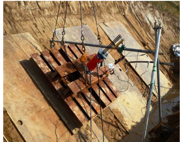
写真,4 引抜き試験状況
