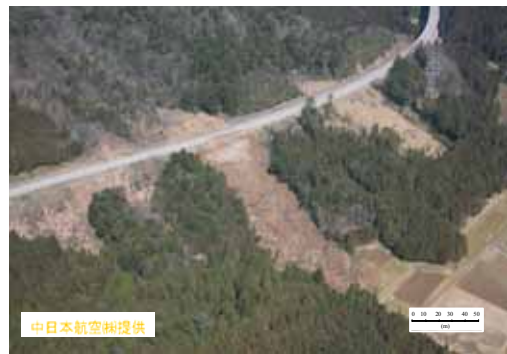
写真-2 谷埋め盛土崩壊地区(その2)
