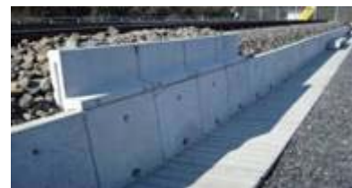
図-2 RCバラスト止めの施工例
