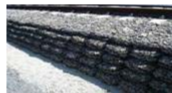
図-5 ジオテキバッグ軌道構造の施工例
