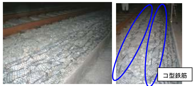
図 - 32 敷設状況(鉄筋打ち込み前・後)
