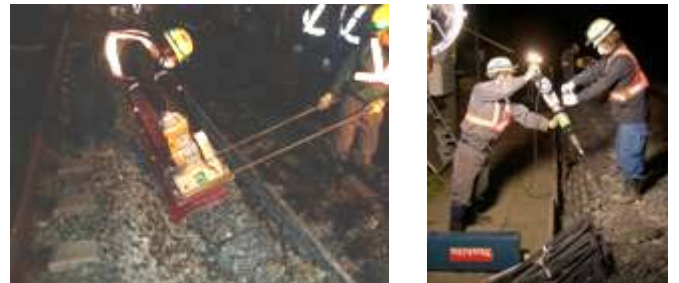
図 - 31 施工性試験(転圧状況、補強鉄筋打ち込み)
