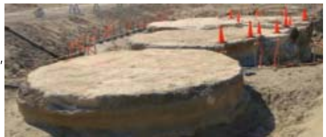
写真 - 1 砂地盤改良体の状況(SJ 工法)
