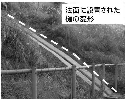
写真-2 法面のはらみ出し
