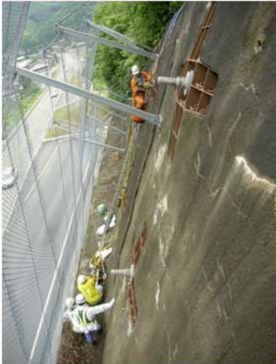
図 - 3 SAAM ジャッキを用いた高所での作業状況
