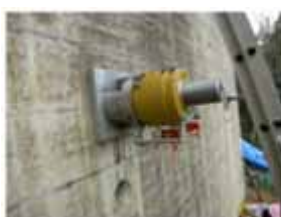
ジャッキの設置
