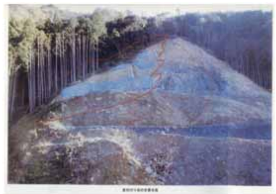
図 - 5 のり面の地質状況
