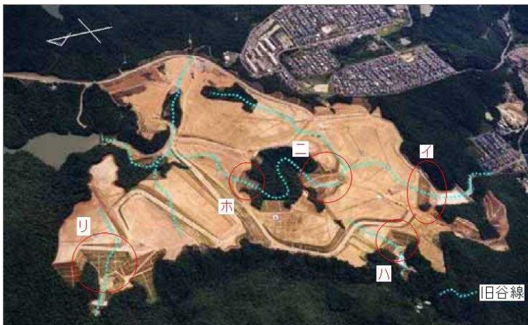
図-1 造成地の空中写真(1998年11月)と盛土検討位置
