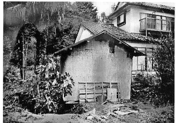
3) 浅所陥没とスロッシングによる噴砂
