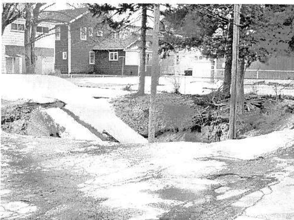
写真 - 1 廃坑の存在する地域における陥没や沈下
