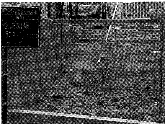
図 5 無対策時の全体破壊状況
