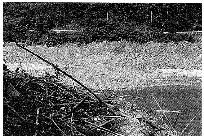
写真-3 倒木が堆積した矢作ダム湖
